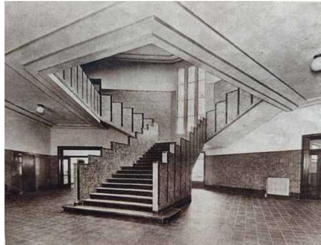
Twee foto's uit het tijdschrift Bâtir van 1936: een buitenaanzicht met de vijvers op de voorgrond en de grastaluds opklimmend naar het schoolgebouw, die mooi de link weergeven tussen het gemeentepark en het schoolgebouw; en de trappenpartij in art-decostijl in de inkomhal van de PTS campus Boom (uit Bâtir , second numéro consacré aux écoles modernes, 45, 1936)
