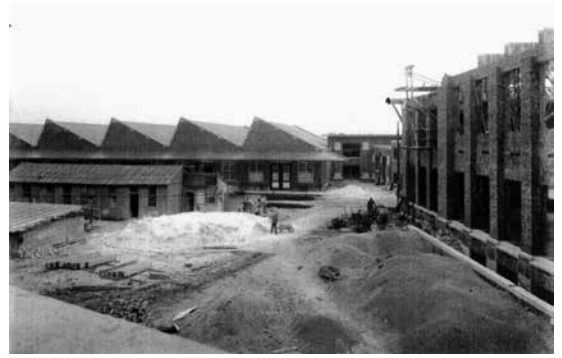
Bouw van de klassenvleugel, met op de achtergrond van links naar rechts de voltooide werkhuizen, turnzaal, refter en conciërgewoning (© Vlaams Architectuurinstituut)
