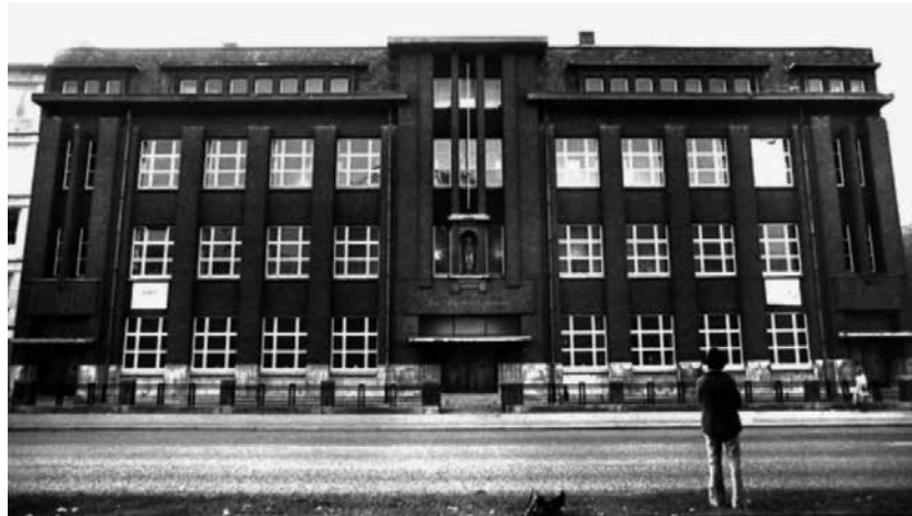
Gevel van het Onze-Lieve-Vrouwinstituut in Berchem naar ontwerp van C. Bal met luifels, steunberen, vensters en een centraal risaliet, sterk gelijkend op die van de PTS van Boom. De ritmering en de vormgeving van de voortuinafsluiting zijn ook erg gelijkend (beeldbank Agentschap Onroerend erfgoed)
