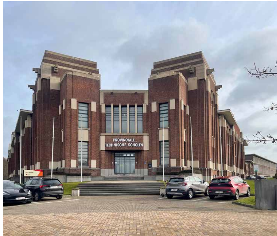
Inkompartij met op de voorgrond de monumentale inkomtrap in blauwe hardsteen, geflankeerd door de grastaluds van het voorhof. De toegang tot het gebouw wordt gemarkeerd door de twee hoektorens met kunststenen detaillering, monumentaal uitgewerkte spuwers en verticale glaspartijen (foto Oswald Pauwels)
