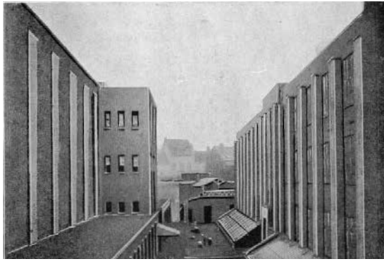
Gevel van diamantslijperij De Daad in Antwerpen naar ontwerp van C. Bal met ook hier verticaliserende elementen in de gevels, zoals lisenen en steunberen (© Vlaams Architectuurinstituut)
