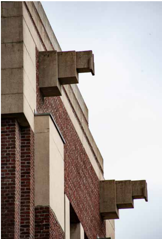
Detail van de geometrisch uitgewerkte waterspuwers aan de inkomtorens. De hoekelementen zijn uitgevoerd in simillpleister op baksteen. De dekstenen en de spuwers zijn van kunststeen met een kern van gewapend beton (foto Oswald Pauwels)
