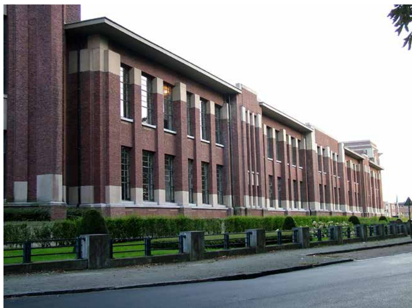
Gevel van de klassenvleugel aan de straatzijde met uitgesproken verticale belijning door de lisenen, steunberen en vensterregisters. Ook typisch zijn de horizontaal benadrukte sokkel onderaan de gevel en de luifel bovenaan (foto Sarah Lacroix)
