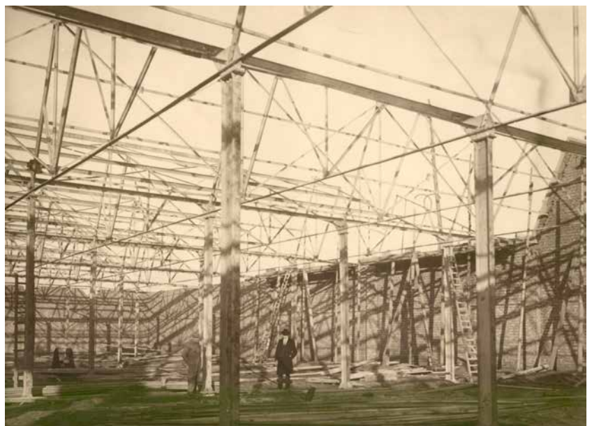
Foto tijdens de bouw van de werkhuizen (© Vlaams Architectuurinstituut)
